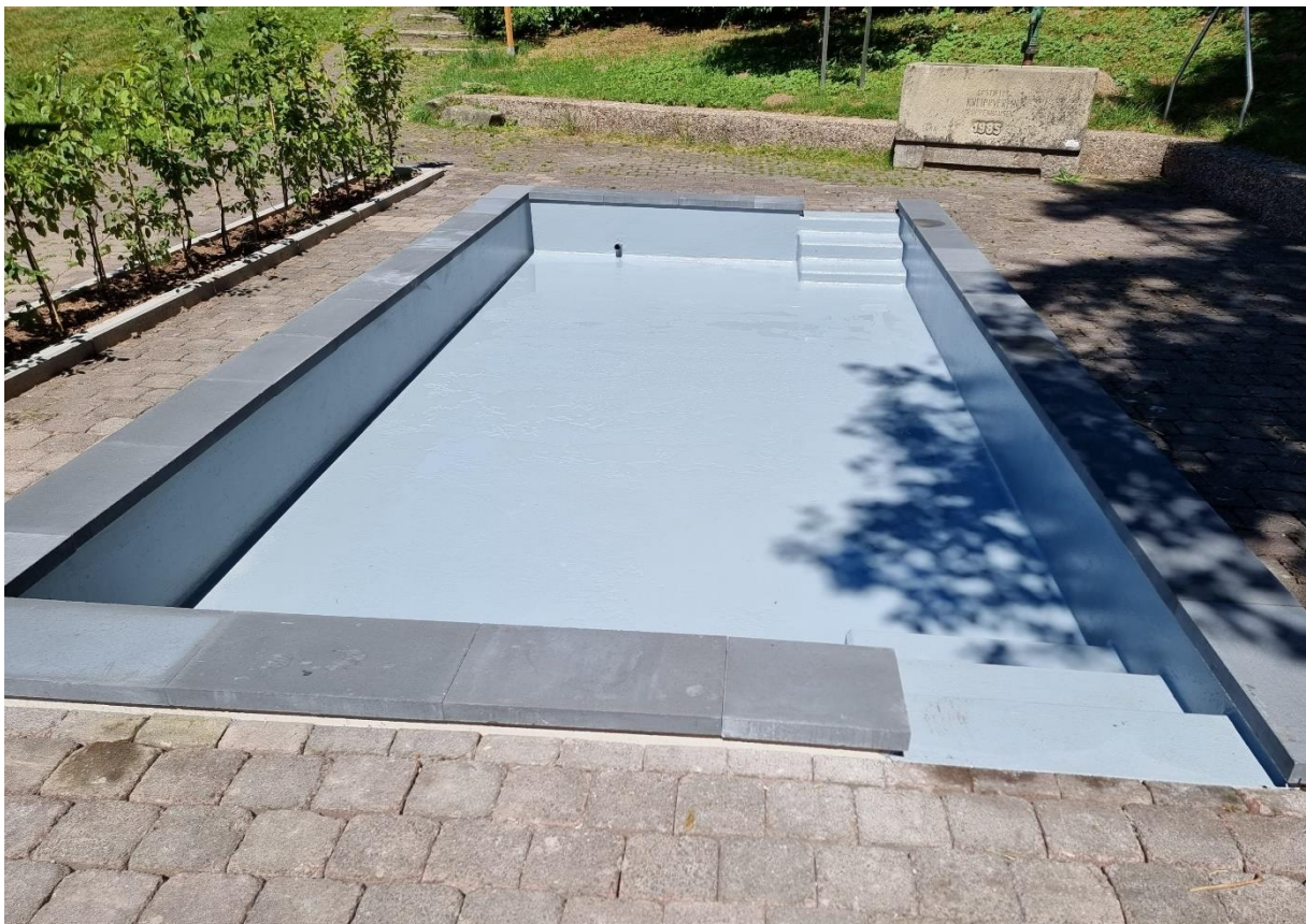
Das neue Wassertretbecken vor seiner Fertigstellung
